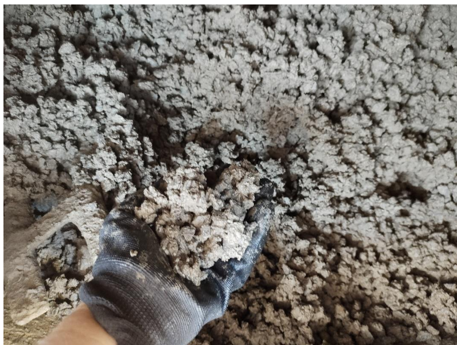
Figura 20 – Concreto em estado fresco, em condições ideais para um pavimento rígido permeável – Índice de Aditivo 0,0010.
